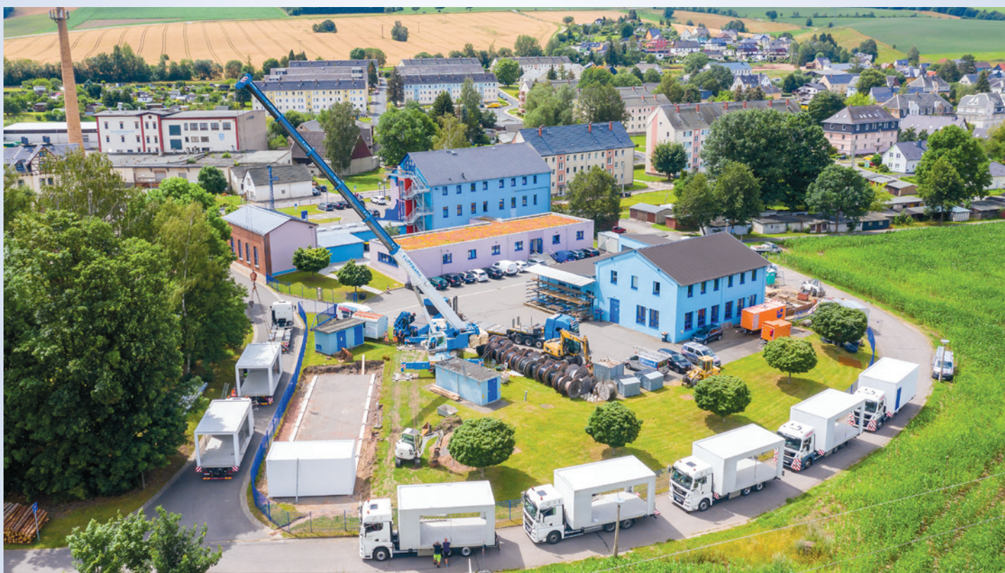
Bild: Alle acht Garagenelemente warten aufgereiht, bis sie mit Hilfe des Krans passgenau auf dem Fundament platziert werden. Foto: Fotoatelier Schmidt, Inh. Kristian Hahn
